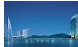
Wuxi Chiway Centre
