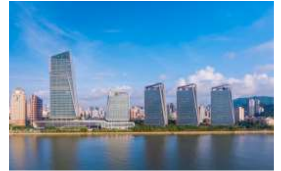
Yanlord Marina Centre-Section B, Zhuhai 仁恒滨海中心-B标段, 珠海
