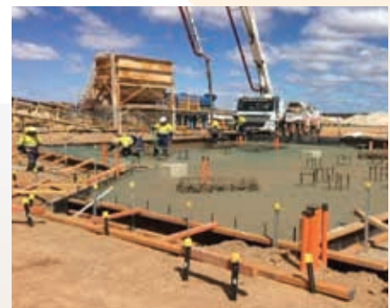
Area 130 Concrete Pour
