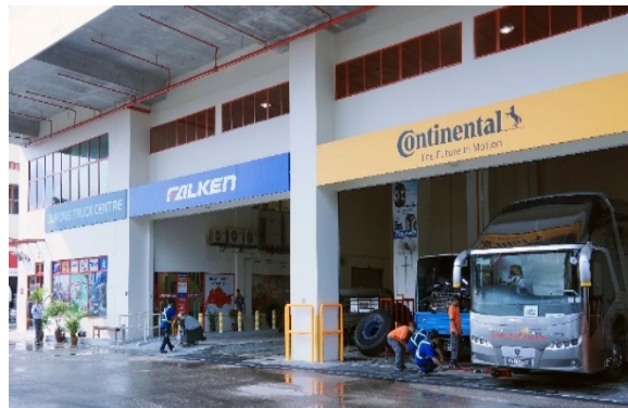
Truck centre, 21 Lok Yang Way
