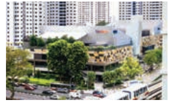
4 BUKIT PANJANG PLAZA
