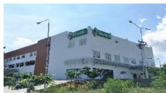
Siloam Hospitals Labuan Bajo
