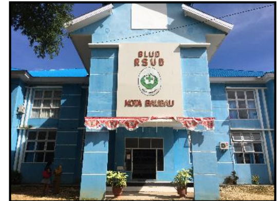
2 RSUD Kota Baubau
