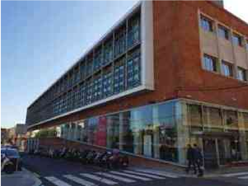
IL-LUMINA BUILDING, C/GASPAR FABREGAS I ROSES 81, ESPLUGUES DE LLOBREGAT (BARCELONA)
