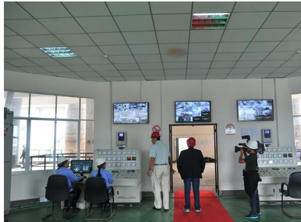
P4 factory control centre 黄磷控制室
