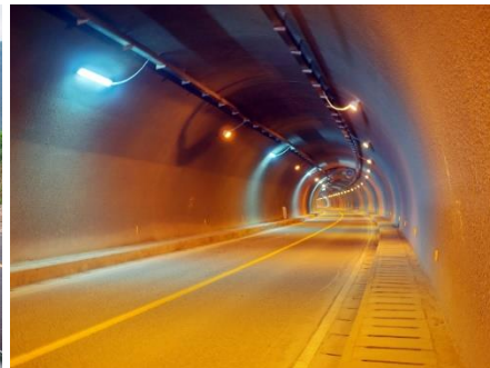
云湖二号隧道 (Yunhu No.2 Tunnel)
