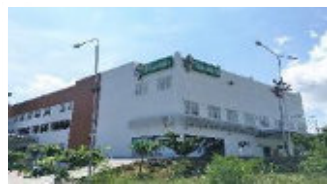
Siloam Hospitals Labuan Bajo
