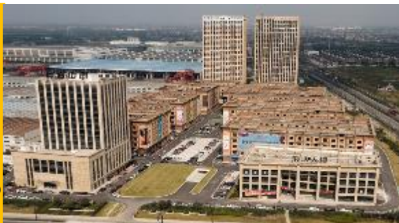
Stage 1 Bei Gang Logistics (北港物流一期)
