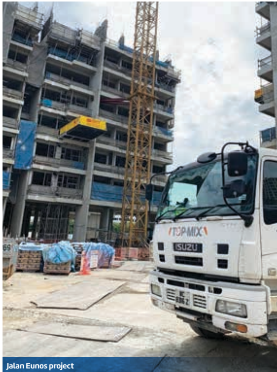
Jalan Eunus project
