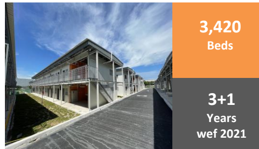
Westlite Jalan Tukang
