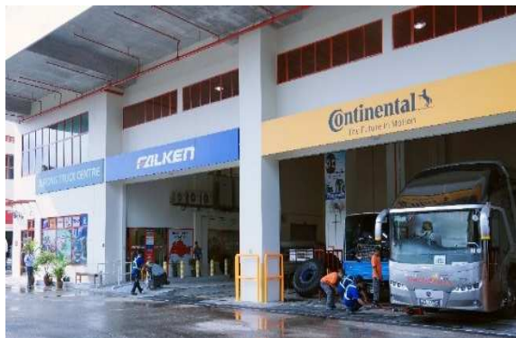
Truck centre, 21 Lok Yang Way
