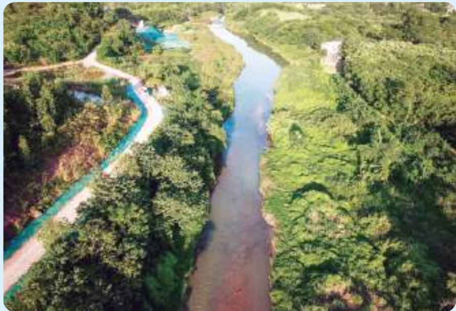
Nanning Shuitang River Project 南寧水塘江項目
