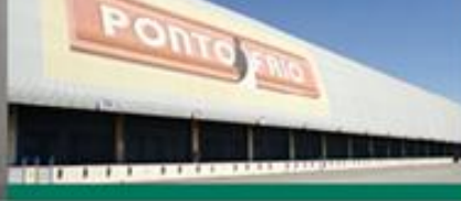
GLP Park Ponto Frio Guarulhos Brazil
