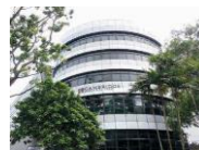
9 Bukit Batok Street 22
