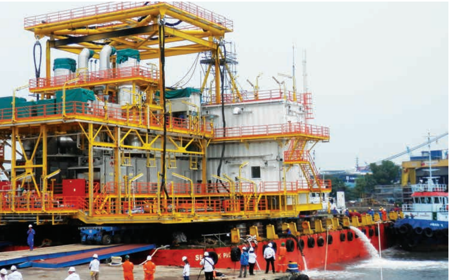
Topside module load-out
