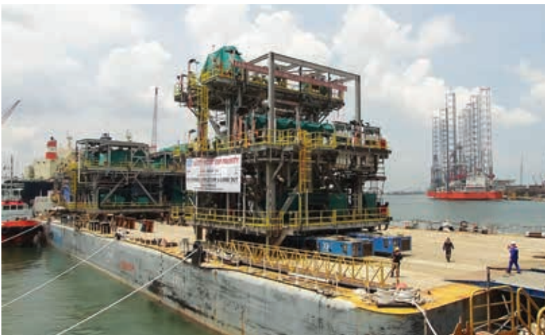
Topside module load-out
