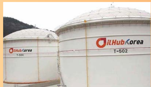
OKYC 韩国丽水枢纽油库有限公司
