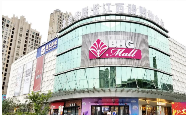
Hefei Changjiangxilu 合肥长江西路
