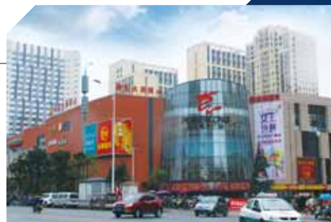
CHONGQING HECHUAN POWERLONG PLAZA
