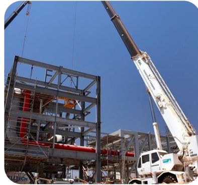
Pluto LNG Project, Karratha
