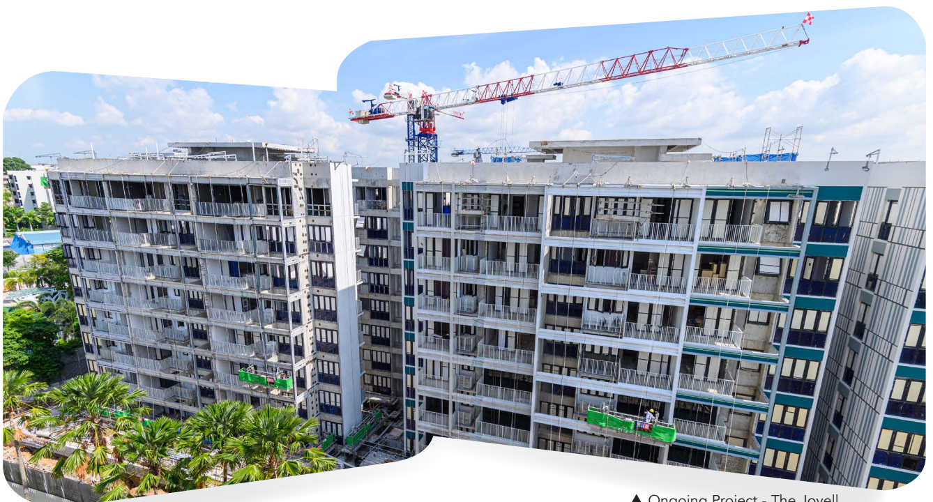
▲ Ongoing Project - The Jovell
