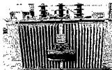
เอกวิฐ 800 KVA ไฟฟ้า 22000 โวลต โวลต 400/230 โวลต ๒ 2545
