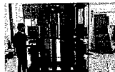
ตู้ MDB 1600 A ๒ CAPACITOR 50kvar 6 ตัว ตู้ MDB 1600 A ๒ CAPACITOR 50kvar 6 ตัว
