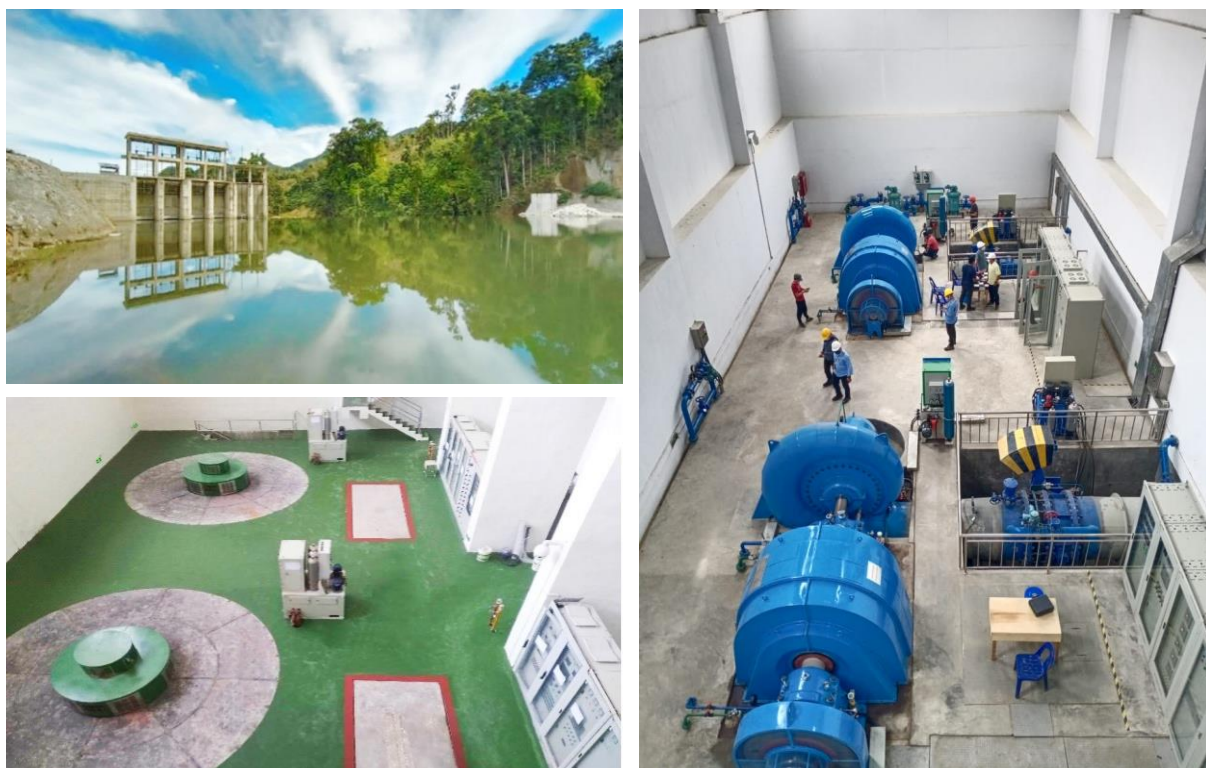
從左上開始，順時針方向：Anggoci 進水堰、Sisira 發動機房、Anggoci 渦輪動力機房
