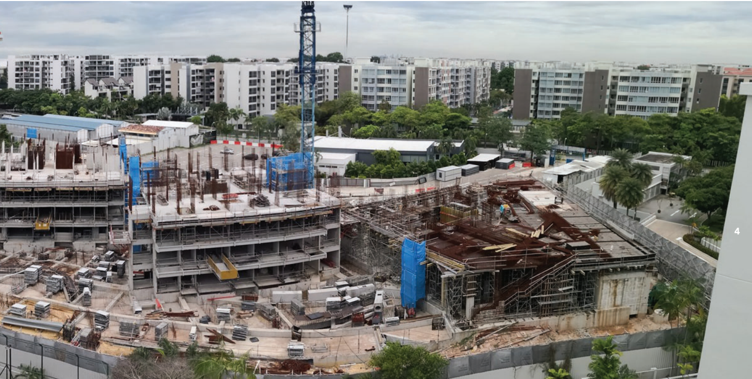
▲ Ongoing Project - The Jovell
