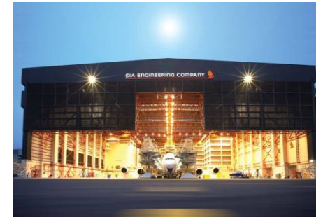
Hangar 6 Apr 2010 1 bay: A380 & B777-300ER
