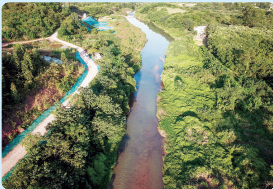
Nanning Shuitang River Project 南寧水塘江項目
