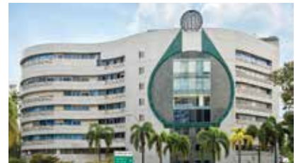
16 1 Bukit Batok Street 22
