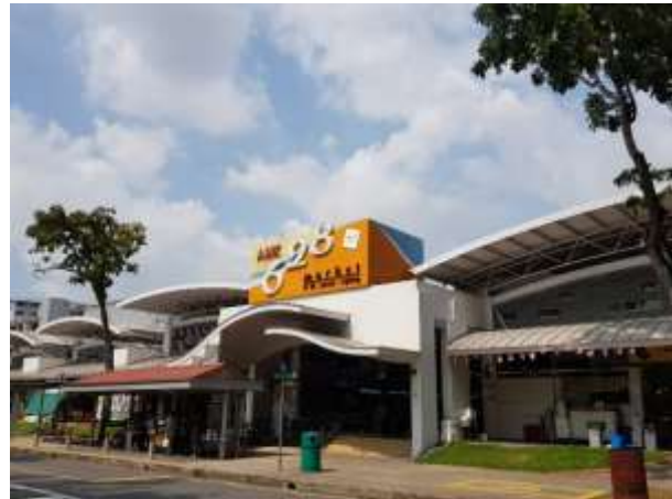
628 Ang Mo Kio Ave 4 Market
