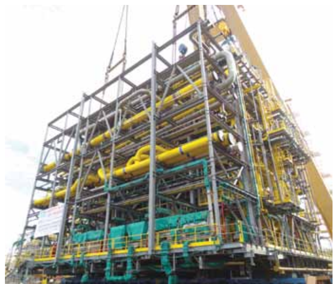
FPSO Cidade De Saquarema, CO 2 Compression Module
