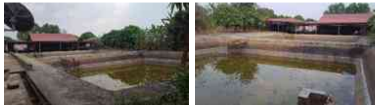
External View of the Subject Property (D)
