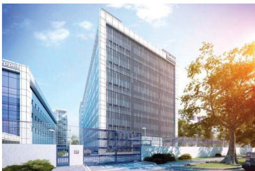
Keppel Datahub 2, Singapore
