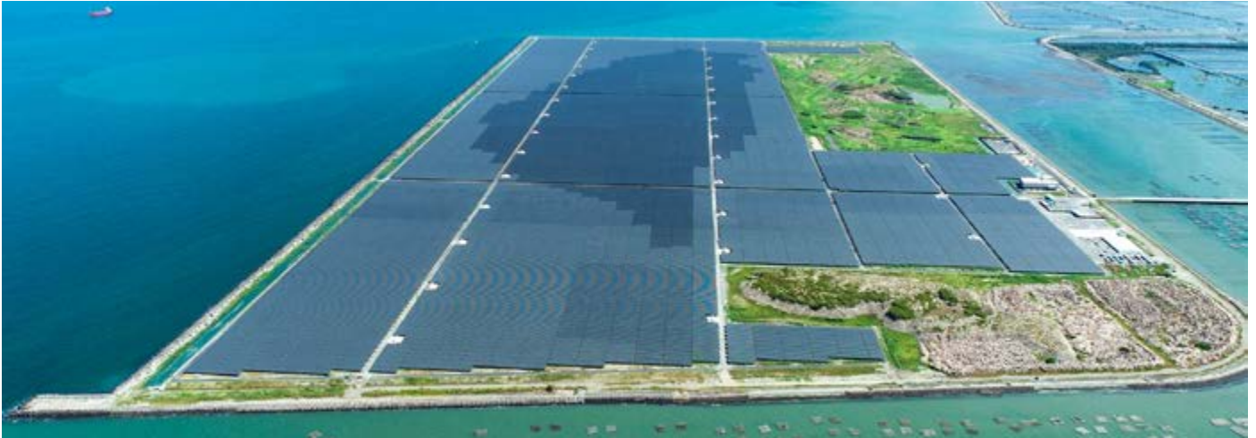
272 MW E2 Solar Project in Taiwan
