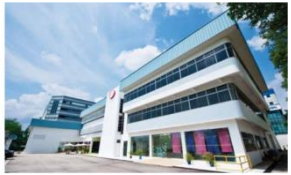
2 Ang Mo Kio St 65
