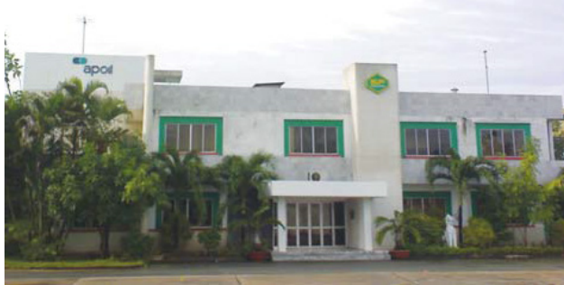
Factory office & R&D Laboratory, APSP, Vietnam 环球西贡工厂办公室与研发中心
