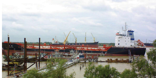
APSP Jetty with 25,000mt berth 环球西贡的 2 万 5 千吨泊位码头
