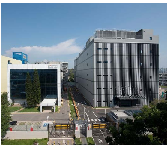
Keppel Datahub and Keppel Datahub 2, Singapore
