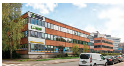
7 Mäkitorpantie 3b, Helsinki
