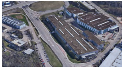
5 Göppinger Straße 1 – 3, Pforzheim
