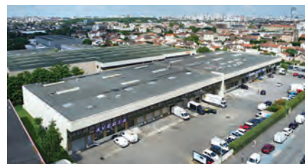
9 Parc Locaparc 2, Vitry-sur-Seine
