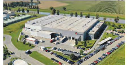
3 Moravia Industrial Park, Uherské Hradiště
