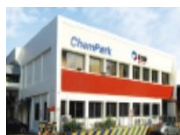
1 Third / 4 Fourth Lok Yang Rd
