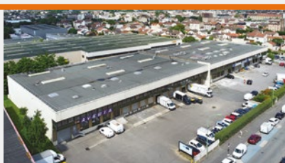
11 Parc Locaparc 2, Vitry-sur-Seine
