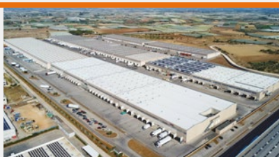
5 Strada Provinciale Adelfia, Rutigliano
