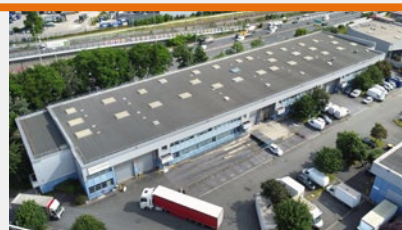
6 Parc Urbaparc, La Courneuve
