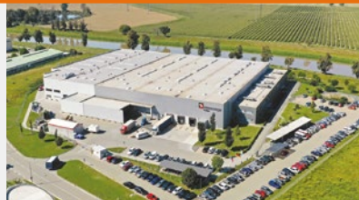
3 Moravia Industrial Park, Uherské Hradiště
