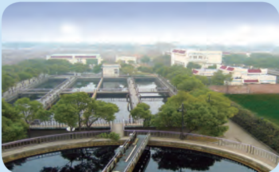
Jiangyin Waste Water Treatment Project 江陰污水處理項目
