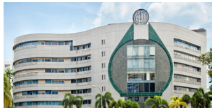
16 1 Bukit Batok Street 22
