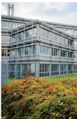
Kelsterbach Data Centre
