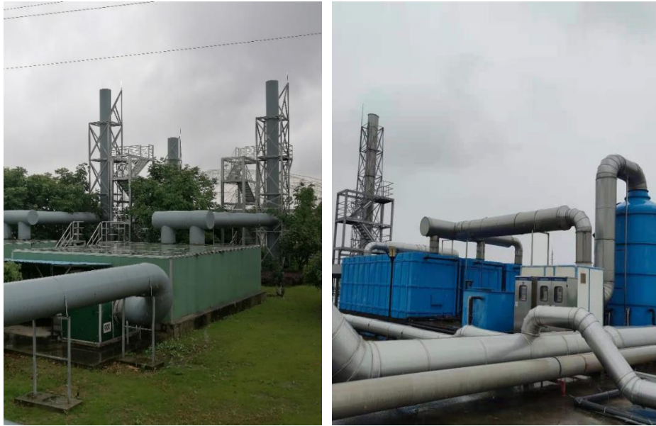
圖 6 武漢漢西污水處理廠除臭設備（左圖）；上海奉賢西部污水處理廠除臭設備（右圖）
