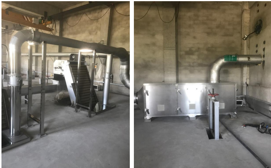
圖 7 哈爾濱市呼蘭區老城區第二污水處理廠項目的細格柵除臭設施
