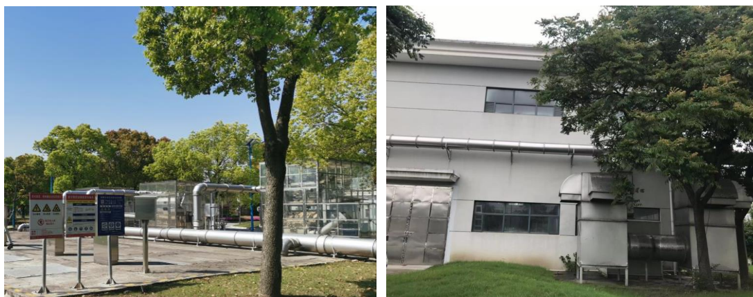
圖 5 青浦第二污水處理廠粗格柵及污泥脫水機房
