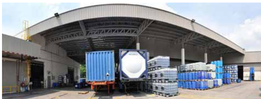
A.I.M. Chemical Warehouse 子公司 A.I.M. 的仓库
