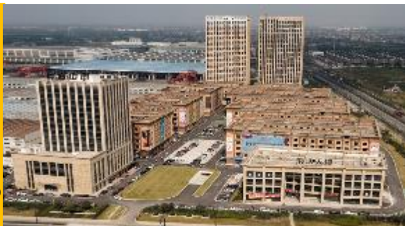
Stage 1 Bei Gang Logistics (北港物流一期)
