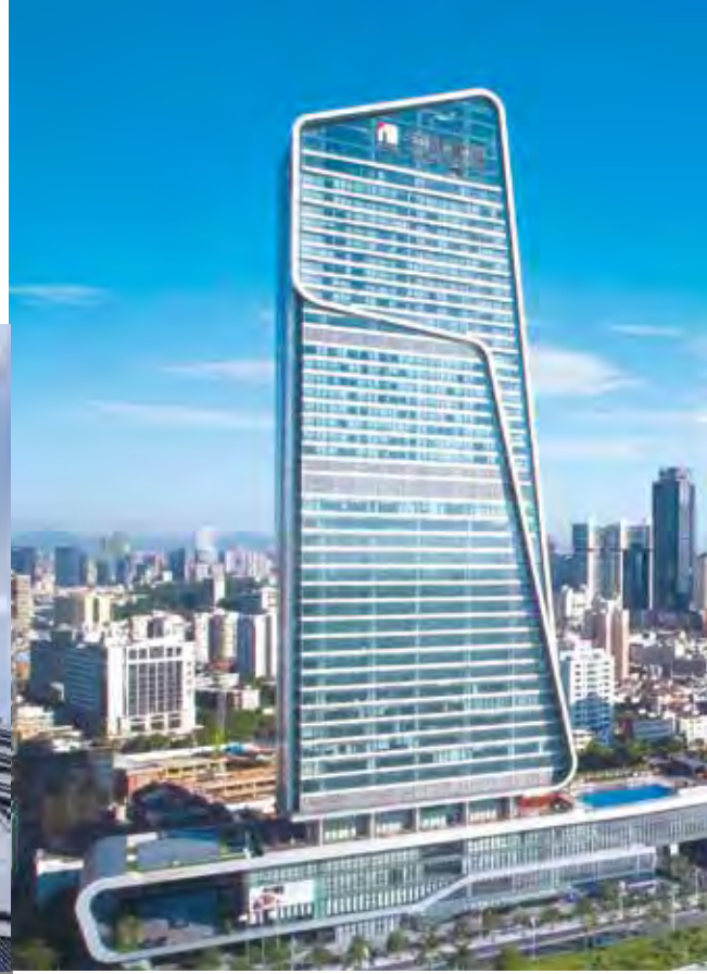
Yanlord Marina Centre, Zhuhai, PRC 仁恒滨海中心, 珠海, 中国
