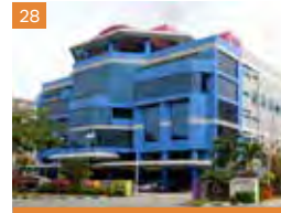
28 521 Bukit Batok Street 23
