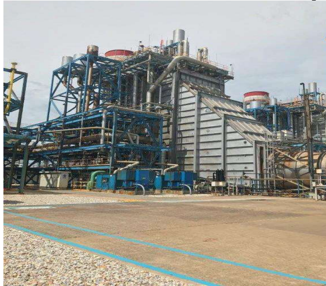
Figure 9-4: HRSG at Altamira II
