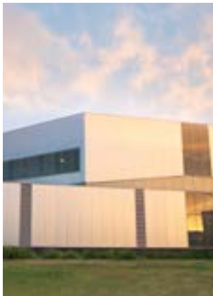
iseek Data Centre
