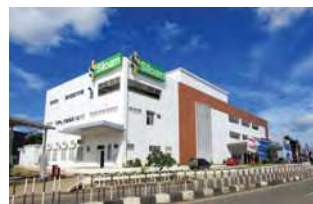
Siloam Hospitals Baubau & Lippo Plaza Baubau
